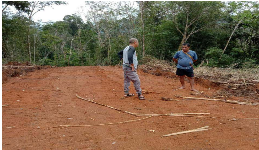
Gambar Pembangunan Jalan Pertanian Desa Kudangan Seberang
